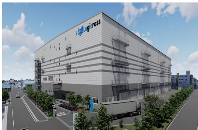
座間倉庫 ロジクロス座間 神奈川県座間市 2024年1月開設予定
