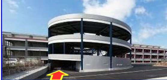
横浜貨物センター所在施設の正面入口
