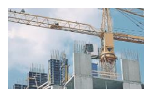
建設 ロジスティクス
